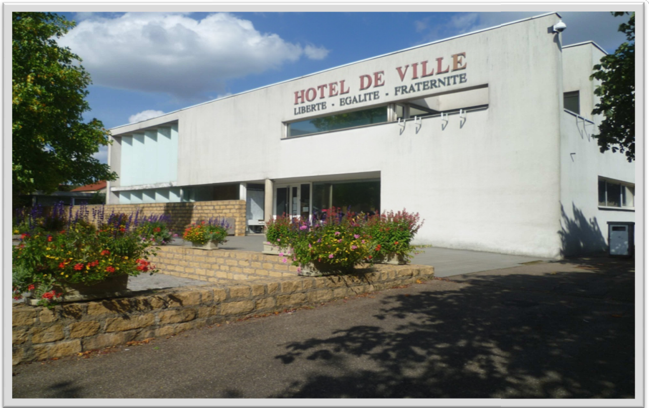
Entrée: façade ouest
