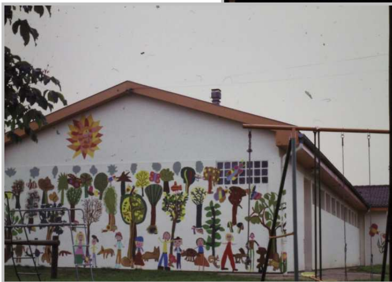
Les petits : pignon ouest
