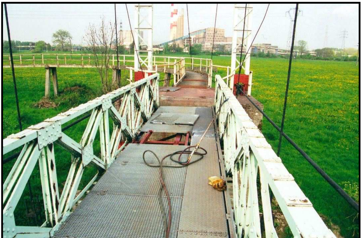
Réfection d'une partie du tablier en 1981
