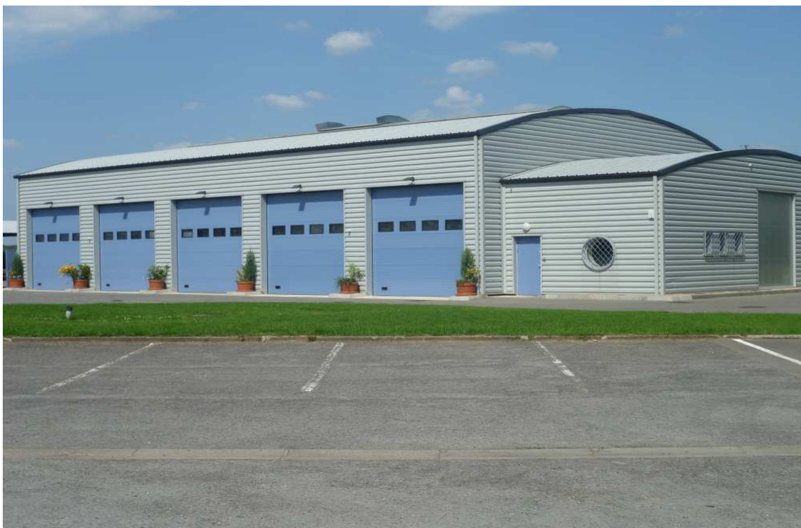
Bâtiment des services techniques de la ville
