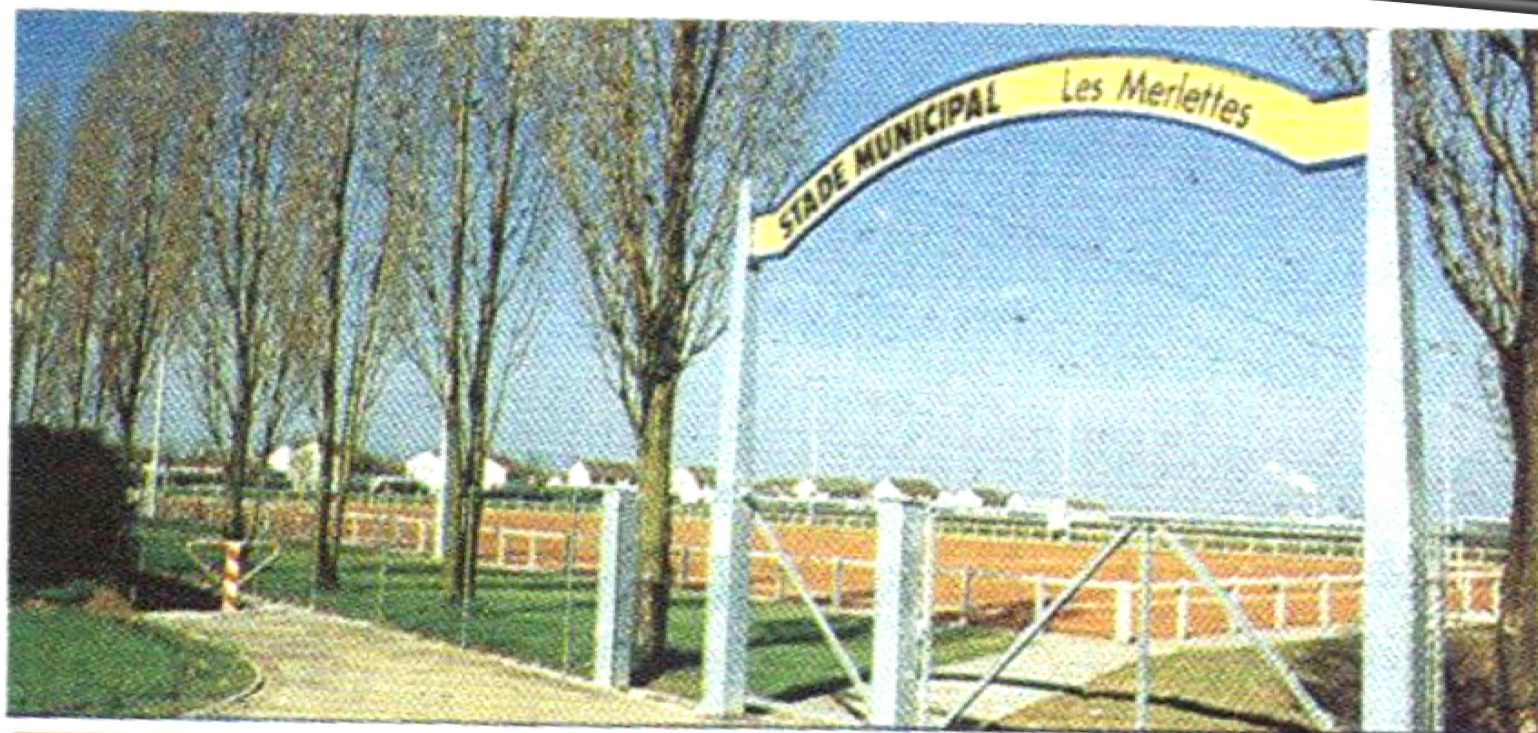
Le terrain de football à sa construction en stabilisé (1991)
