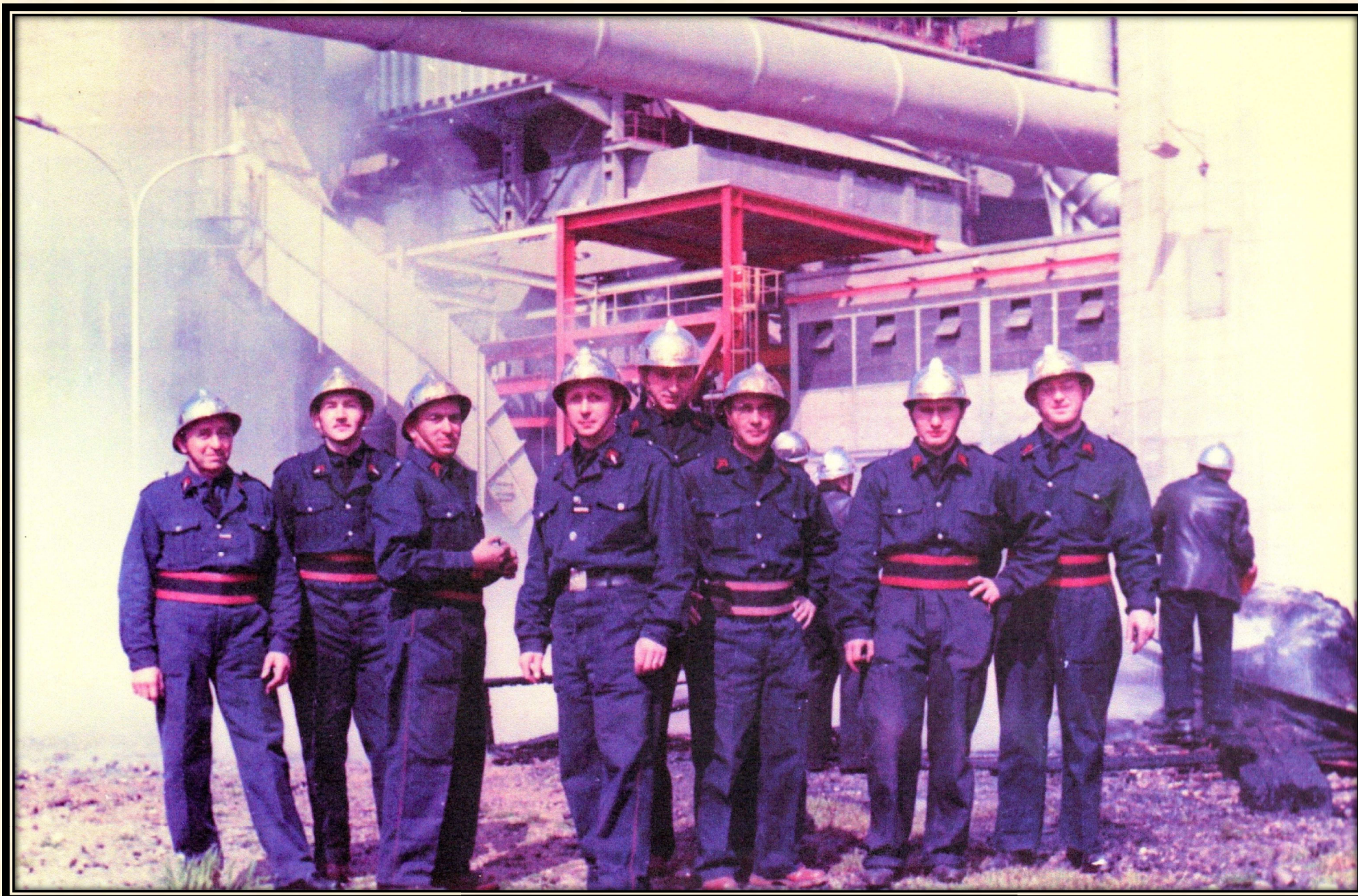
Manœuvres à la Centrale Sidérurgique de Richemont
